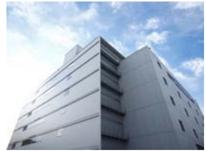
データセンター
