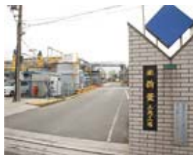
二島工場外観
