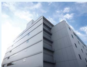
データセンター
