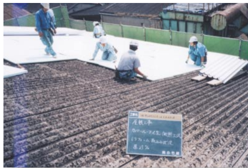
屋根の断熱工事
