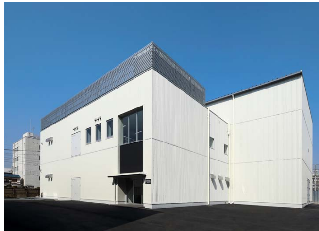
HVDC 検証棟外観
