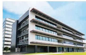
ZEB関連技術実証棟「SUSTIE」
