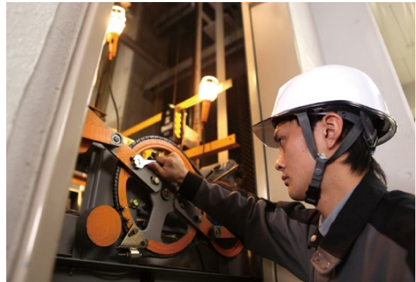
メンテナンス作業の様子
