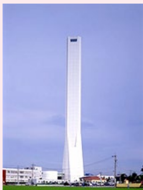
エレベーター試験塔 「SOLAÉ（ソラエ）」
