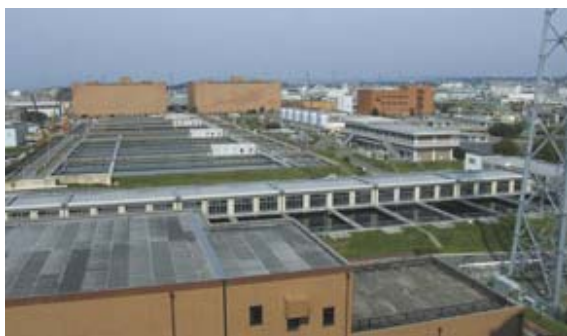
村野浄水場様の浄水場全景
