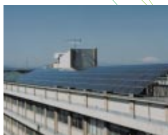
太陽光発電システム
