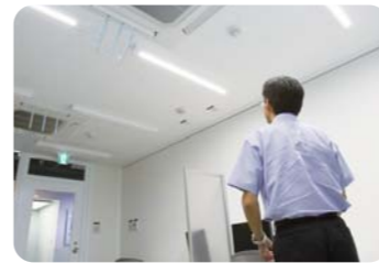
06 ドアを開けて部屋に入ると、部屋の照明とエアコンが作動しました。
