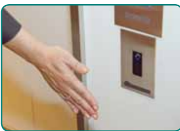
08 まずは乗場に設置されたセンサーに手をかざしてエレベーターを呼びます。
