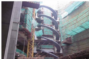
ボックスビーム設置風景 中間支持を排した洗練された構造にするため、ラスベガスの「ザ・フォーラムショップス」で実績のあるボックスビームと呼ばれる人工床を採用。
