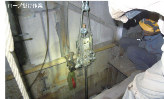
据付作業の現場から：高さ600mを超える狭い昇降路内で、慎重に進められた超高速エレベーターの据付作業。世界最高速のスピード、低振動・低騒音を実現した技術力のみならず、大きな事故もなく完遂することができた「安全の品質」も三菱ブランドの誇り。
