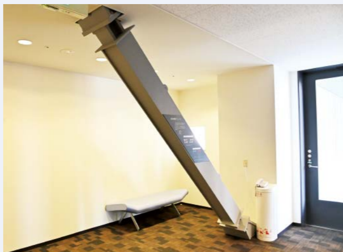
座屈補剛ブレース 一般的な耐震基準の20%増して設計されたキャンパスに設けられた補強材。圧縮時にも座屈することなく、安定した地震エネルギー吸収能力を有する。
