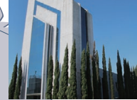
メキシコシティFAセンター Mexico City FA Center Mexico FA Center Mexico Branch, Mitsubishi Electric Automation, Inc.
