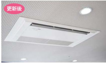
斜め天井には、ビルトイン形を下吸込み仕様で設置
