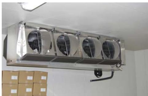
▲原料保管庫内には当社製冷凍用ユニットクーラを2台設置。原料の劣化を防ぐため-20℃で保管。
