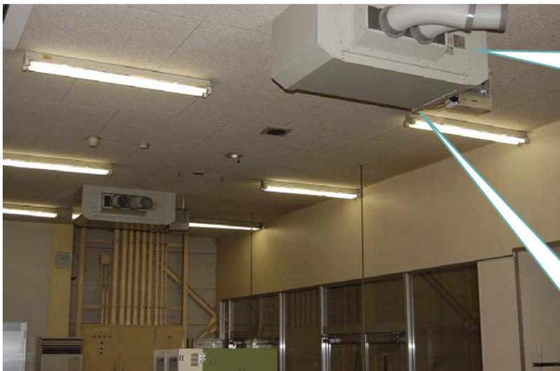
▲焼き工程に移る前の「供給室」にて天吊薄型タイプ除湿機KEH-P08Aを2台ご採用。既設の空調機と合わせて温湿度を管理。
