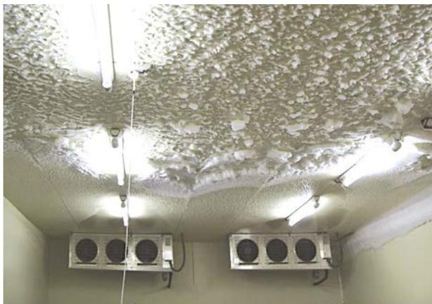
吹出しダンパ・吸込みフード取付け前の天井面天井一面に霜付きが激しく、霜取時にユニットクーラからの熱・蒸気の流出により天井面への霜・露付き、水滴落下が発生している。
