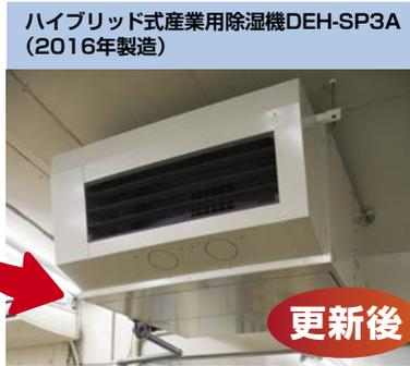
◀一体型除湿機から、圧縮機ユニットが分離したハイブリッド式産業用除湿機(天吊形)への更新を実施。既存除湿機を載せていた架台を再利用して圧縮機ユニットを設置
