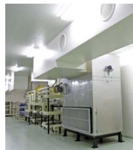
◀クーリング室のエアハンドリングユニット。焼成後のパンはスパイラルコンベアに載せて冷ます。食パンの場合、約25℃・湿度55~60%の室内で2時間ほどかけて芯温を35℃以下にする
