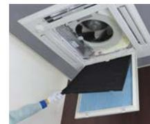
三菱電機のアレル除菌フィルターは、吸込みグリルとプレフィルターの間に挟み込むだけ!簡単な取付けでお手軽にウイルス抑制が可能です。
