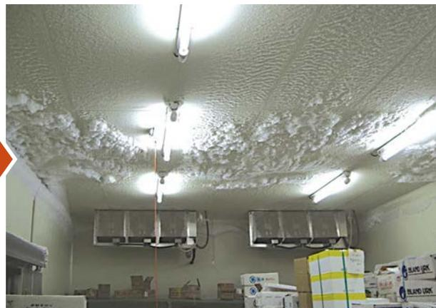
吹出しダンパ・吸込みフード取付け後3.5ヶ月の天井面天井の一部に霜付きがあるが庫内霜付き量は大きく低減されている
