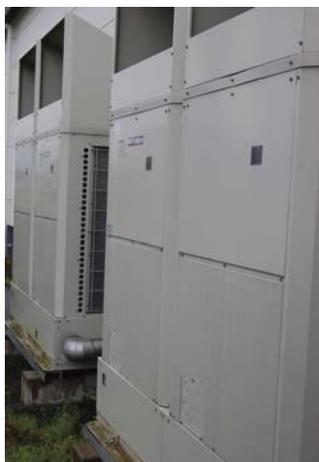
▲屋外には原料保管用冷凍庫の熱源機の当社製R410Aインバータコンデンシングユニット20馬力×2台
