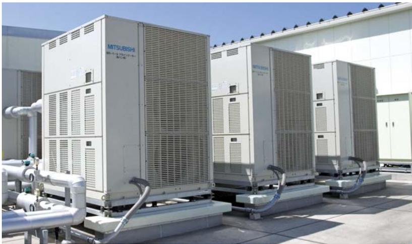
▲建屋東側(南面)の1階屋上に設置された一体空冷式インバーターブラインクーラ(BALV-P40AE×6台)。生地をつくる際のミキシングによる温度上昇を抑えるため、ミキサージャケットにブライン液を使用して冷却する。仕込水の冷却にも使われる
