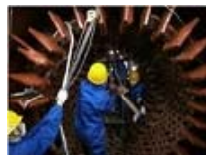
タービン発電機コイルの巻き替え
