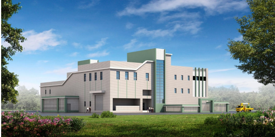
台湾初の STATCOM が採用される「STATCOM 変電所」のイメージ
