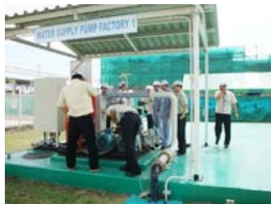
アジアの拠点での環境現場点検の様子
