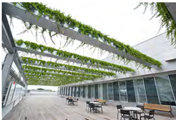
緑化ルーバーへは雨水をためて自動給水
