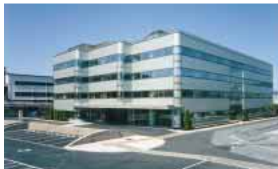
新事務所棟の外観
