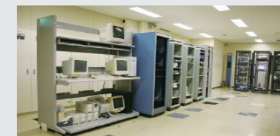
電算機室 不要になった電算機の処分、低消費電算機の導入、空調機の運転台数を減らしたことで消費電力は従来比70%減。スペースは以前の1/3に。
