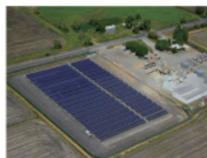
大規模発電設備
