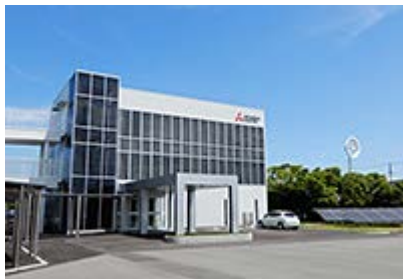
実証棟建屋外観
