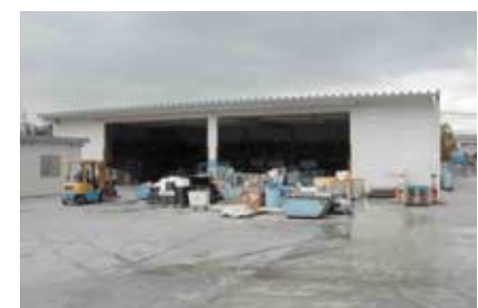
系統変電・交通システム事業所に新設されたリサイクルセンター
