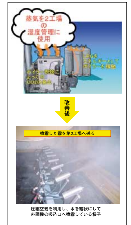
カネボウ菊池電子(株)における二流体加湿システム導入例
