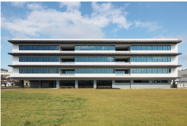
左：三菱電機 ZEB 関連技術実証棟「SUSTIE」南面。Low-e 複層ガラスと水平庇で、屋内の明るさを確保しつつ冷暖房負荷の低減を図っています。 右：カーボンニュートラル賞表彰式（2024 年 5 月 15 日（水）、建築会館ホール／東京都港区にて）における表彰の様子。
