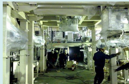
移載装置据付け
