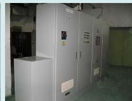
宇通汽車殿向制御盤 OMRON製PC・GOT使用
