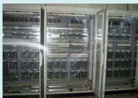
一汽轎車殿向搬送制御盤 三菱INVをCCリンクで駆動
