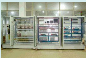
済南汽車向制御盤三菱Q シリーズを使用
