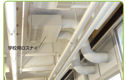
学校用ロスナイの給気・排気のダクト配管の様子です。
