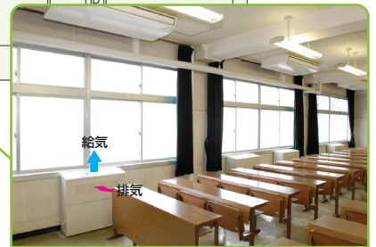
床置形学校用ロスナイの設置状況。壁と机の間のスペースに、違和感なく設置されています。
