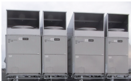
▲屋上に並んだグランマルチ。防雪対策も徹底。
