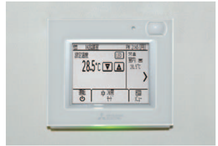
▲人感センサー、照度センサー、温度センサーを搭載し、教室を自動で省エネ
