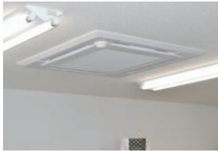
▲室内ユニットはムーブアイ付きの4方向カセットを採用し、足元まで快適
