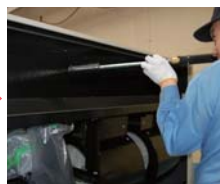
プレナムチャンバーを水で洗浄します。
