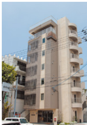
泊港から首里方面に向かう県道29号線沿いに立地。
