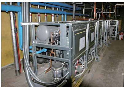
◀機械室に設置されたR410Aリモート空冷式インバータコンデンシングユニット(20馬力×3、30馬力×1)
