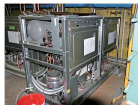
◀機械室に設置されたR410Aリモート空冷式インバータコンデンシングユニット(20馬力×3、30馬力×1)
