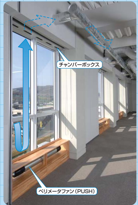
"あえて見せる" 設置をしているペリメータファンは外からも見える。
