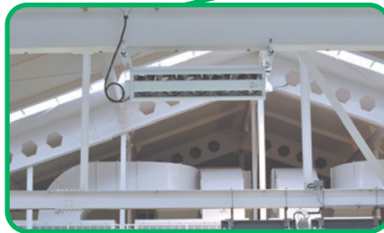
給気ファン(斜流ファン)で外気を供給し、それをエア搬送ファンで作業スペースに当て、涼風感を得ます。
