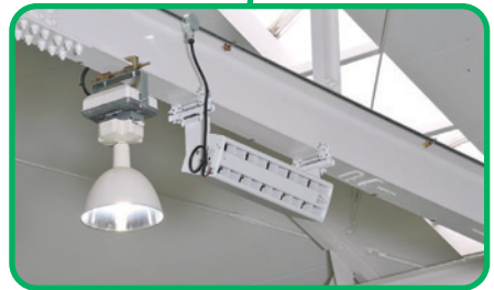
H鋼に予めブラケットを設置しておき、ボルトで挟み吊り下げるだけという、シンプルな施工方法です。
