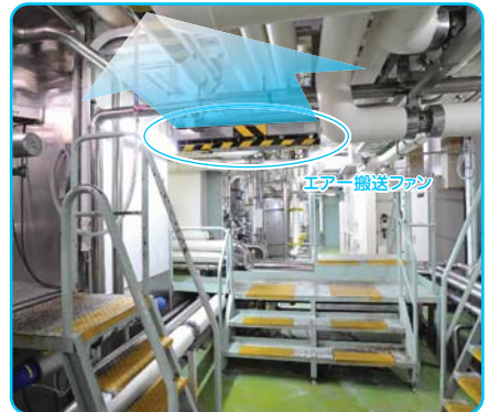
エア-搬送ファンはダクトとダクトの間に吊りボルトを通して設置するなど、その場の状況に柔軟に対応可能。またダクト方式と違い、埃が溜まるスペースが少ないので、食品を扱う建物にも適しています。
