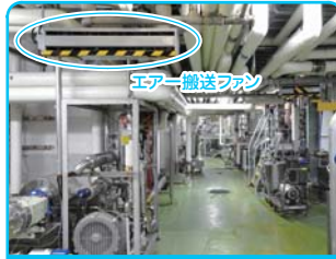
エア-搬送ファンはダクトとダクトの間に吊りボルトを通して設置するなど、その場の状況に柔軟に対応可能。またダクト方式と違い、埃が溜まるスペースが少ないので、食品を扱う建物にも適しています。
