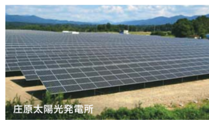
庄原太陽光発電所
