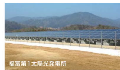
福富第1太陽光発電所
