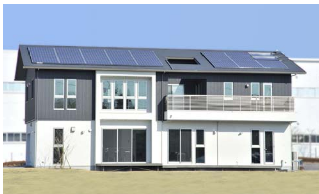
大船スマートハウスの外観
