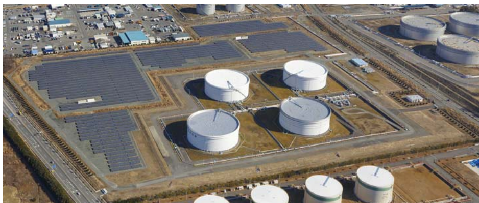
小名浜・泉ソーラー第一／第二発電所（6.2 メガワット分） 設置外観写真（1 月 24 日撮影）
