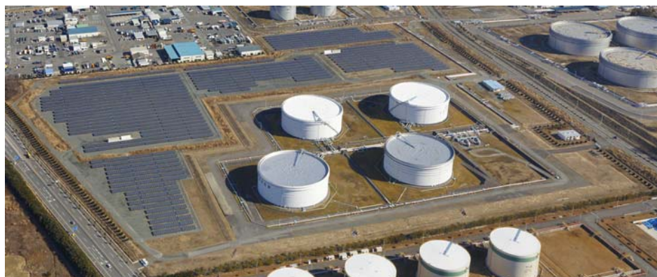
小名浜・泉ソーラー第一／第二発電所（6.2 メガワット分） 設置外観写真（1 月 24 日撮影）
