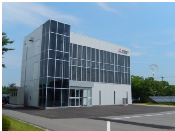
中低圧直流配電システム実証棟 (2016年7月稼働開始)
