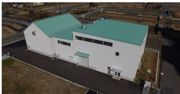
尾張西部浄水場 脱水設備
