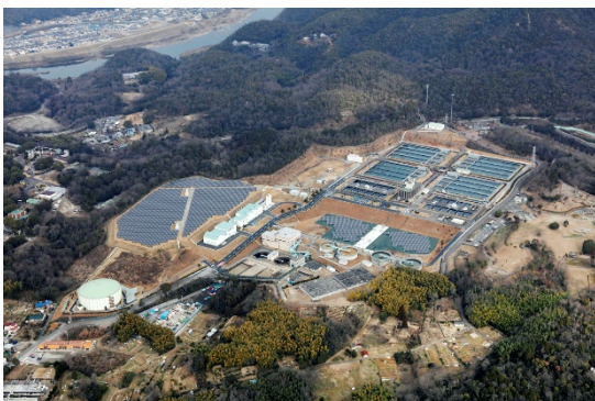
犬山浄水場 脱水・発電設備
