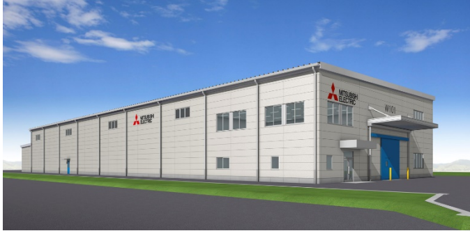
「超電導マグネット新工場」の外観イメージ
