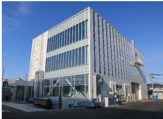
白鷺電気工業新本社ビル
