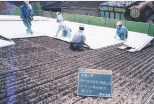
屋根の断熱工事
