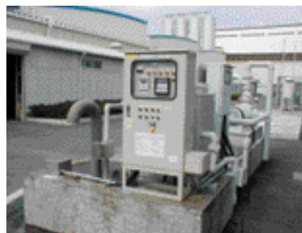
東洋高砂乾電池(株)が導入したpH中和処理装置 ※5) pH: ペーハー。pHの値が高いほどアルカリ性。
