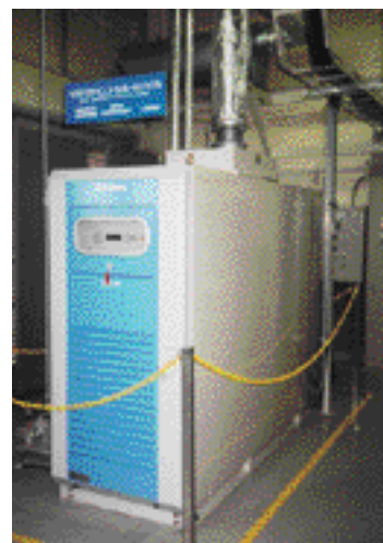
オスラム・メルコ(株)が導入したマイクロガスタービン・コージェネレーションシステム
