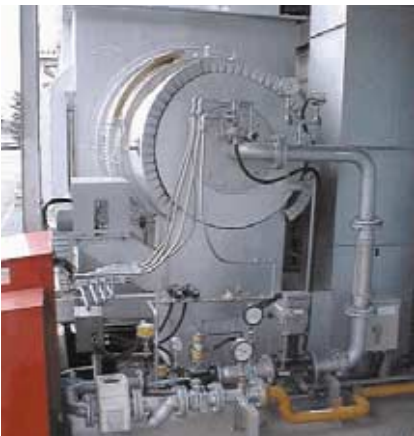
都市ガス用へ変更後の脱臭装置バーナー部位
