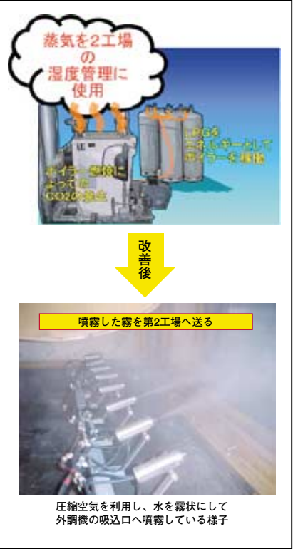
カネボウ菊池電子(株)における二流体加湿システム導入例
