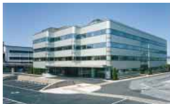
新事務所棟の外観
