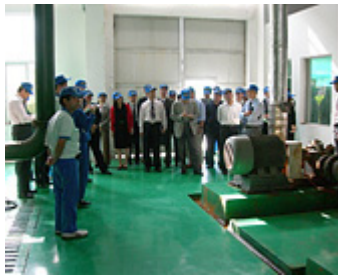
中国での工場ボイラー設備点検
