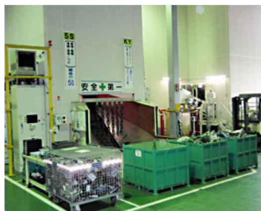
ハイパーサイクルシステムズの基板専用のリサイクル設備
